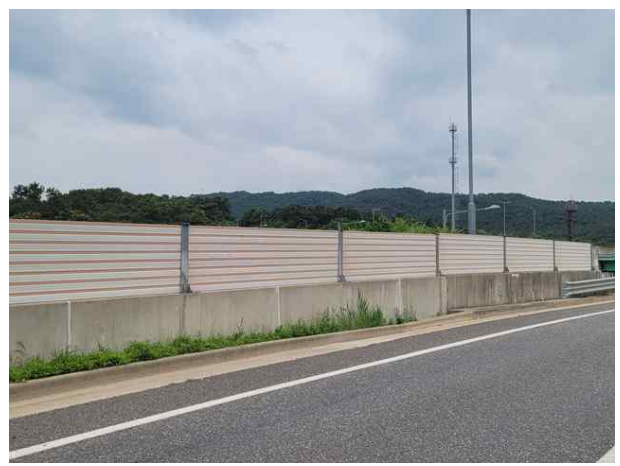
난간 및 연석 전경
